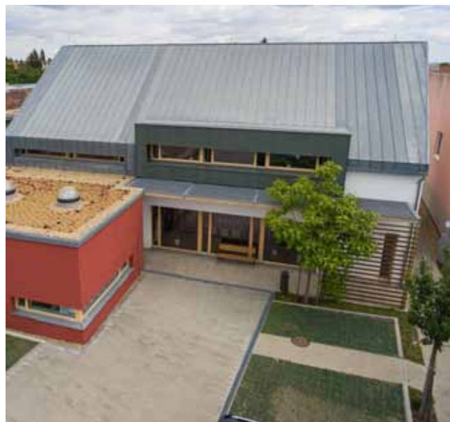
Obr.: Domov pro seniory, vstupní budova | Zdroj: Modřice
