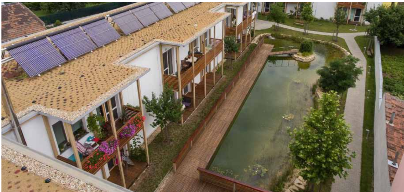
Obr.: Domov pro seniory, střecha a atrium | Zdroj: Modřice
