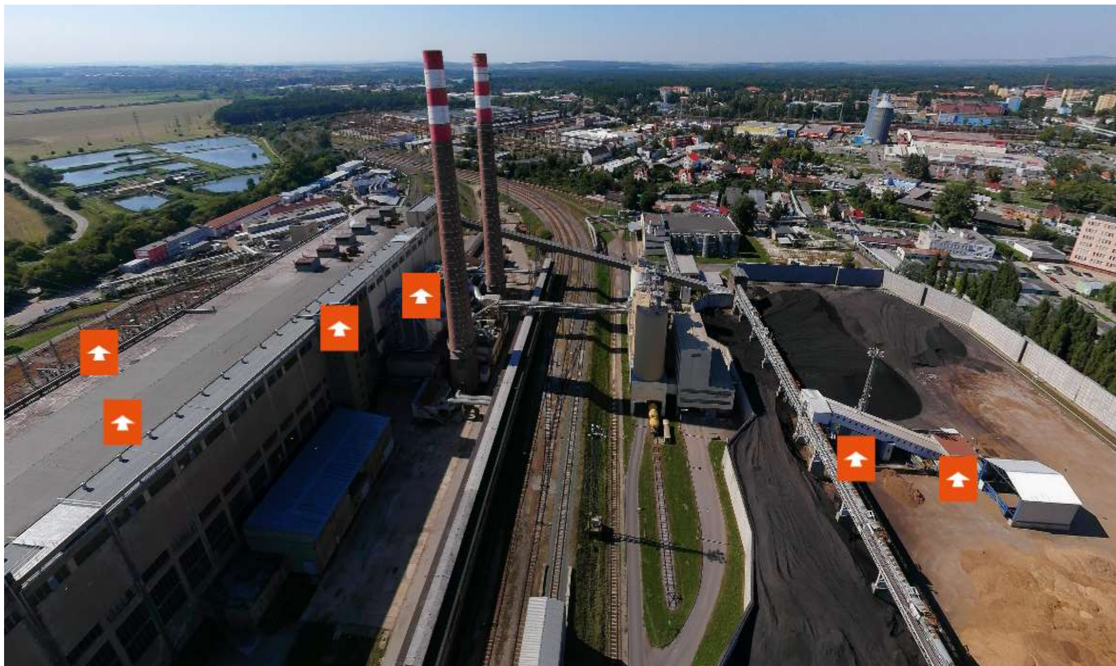
Elektrárna Hodonín, třetí největší elektrárna na biomasu na světě
